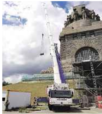
Demontage der Natursteinbalustrade des Unteren Umgangs
