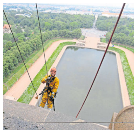
Der Grünbewuchs wurde mittels Seilsicherungstechnik entfernt. Foto: HJW + Partner
