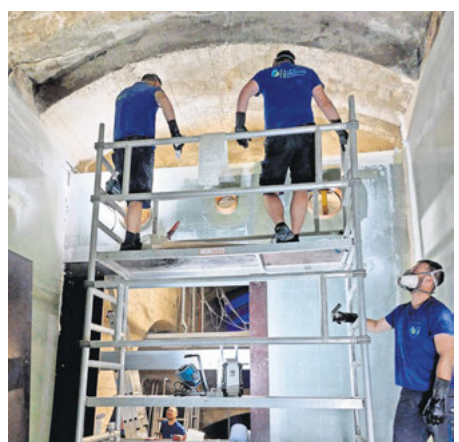
Bau eines Regenwassertanks im Katakombenbereich. Foto: Amt für Gebäudemanagement
