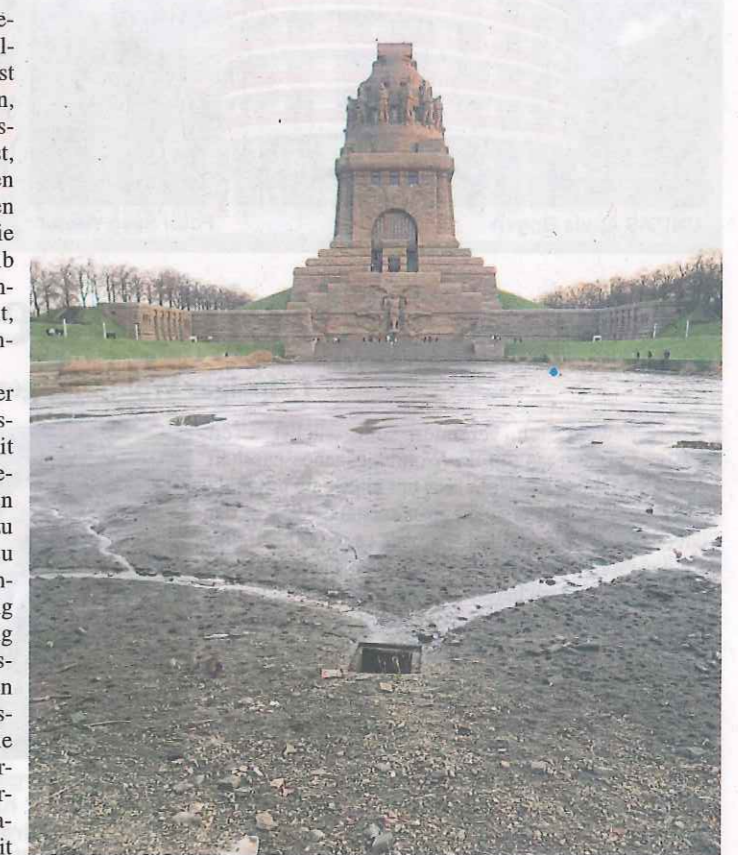
Kein Wasser mehr im Becken, die Sanierung kann beginnen.
